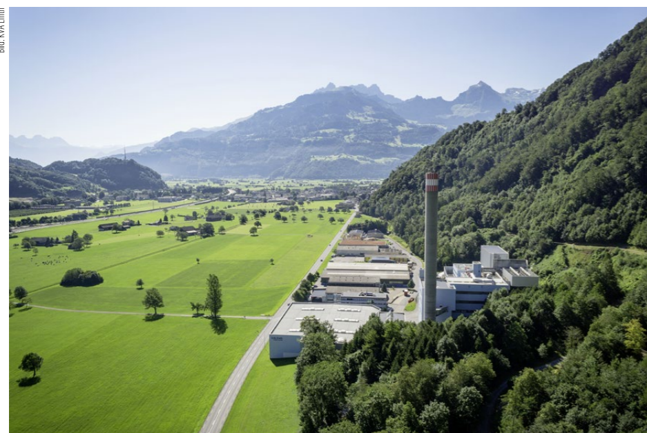
Blick Richtung Glarnerland: Die für die Region so wichtige KVA Linth soll für knapp 200 Millionen Franken erneuert werden.
