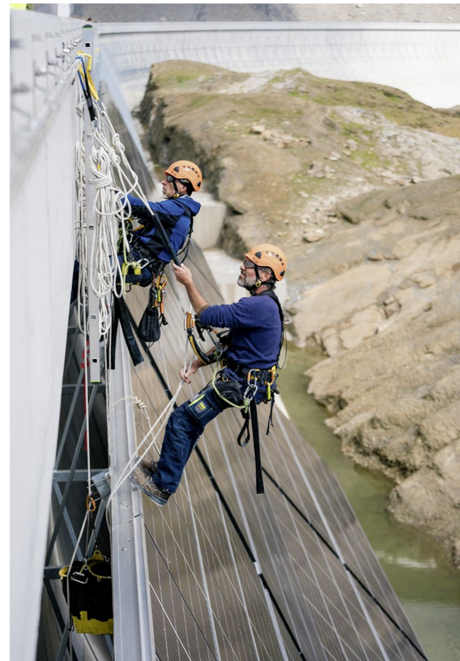
Zurzeit wird beim glarnerischen Muttsee das grösste Solarkraftwerk der Alpen realisiert. Dafür müssen die Photovoltaikmodule erst mit dem Helikopter in die Höhe geflogen werden, um dann an der Stauwand montiert werden zu können.
