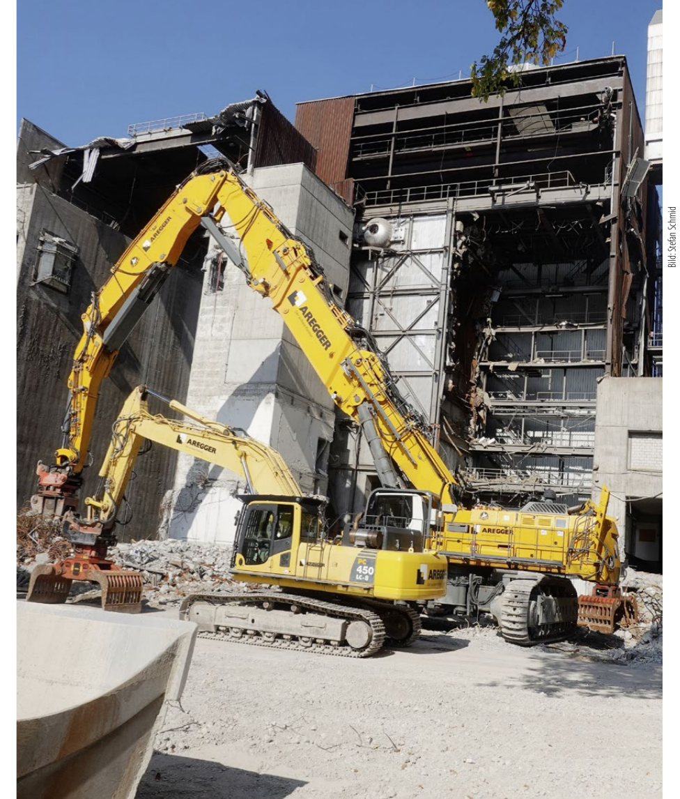
Geplant sind auch höhere Investitionen in Hochbauten für Versorgungsanlagen. Bild: In Zürich wird an der Josefstrasse die Kehrlichtverbrennungsanlage teilweise abgerissen und in eine Energiezentrale umgebaut. Auf dem Areal sind weitere Projekte vorgesehen.
