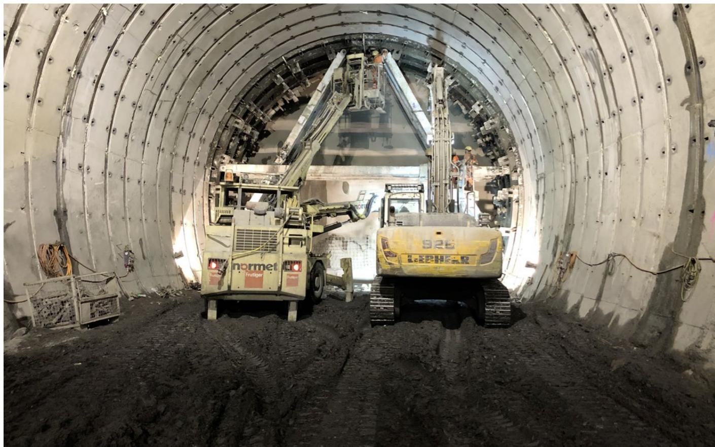
Für den Einbau des Ortbetons der verstärkten Ausbruchsicherung in Etappen von drei Metern wird eine massive Stahlschalung gestellt.
