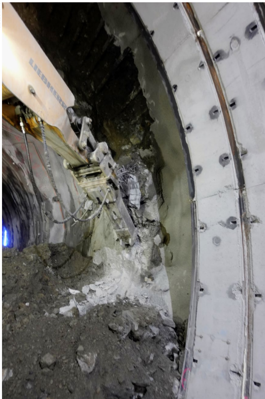
Die Tunneln werden im rückwärtigen Bereich aufgeweitet, um auch dort Platz für den Einbau der verstärkten Ausbruchsicherung zu schaffen.
