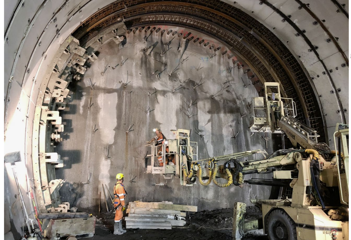
Der Vortrieb erfolgt im Schutz eines Rohrschirms. Auf dem Bild sind die Rohrenden des Rohrschirms zu sehen sowie die gestellten Stahlträger inklusive Bewehrung der verstärkten Ausbruchsicherung. Auf der linken Seite ist bereits ein Teil der Schalung für den Ortbeton der Ausbruchsicherung montiert.
