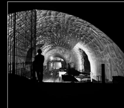
8.11.1974, Zwischendecke Haupttunnel: In der Nähe der Tunnelportale wurde das Innengewölbe aus Beton mit Kunststofffolien abgedichtet, die das Einsickern von Bergwasser verhinderten. Sonst wäre das Bergwasser im Winter auf der Fahrbahn zu Eis gefroren, und Ventilationskanäle hätten vom Eis blockiert werden können.
