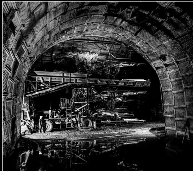
11.2.1973, Lüftungszentrale Motto di Dentro: Zwei Atlas-Copco-Bohrjumbos, über ihnen die Schutzbrücke, auf der ein weiterer Bohrjumbo mit vier Armen installiert ist. Der obere Jumbo konnte bereits die Sprengbohrungen für die Kalotte ausführen.
