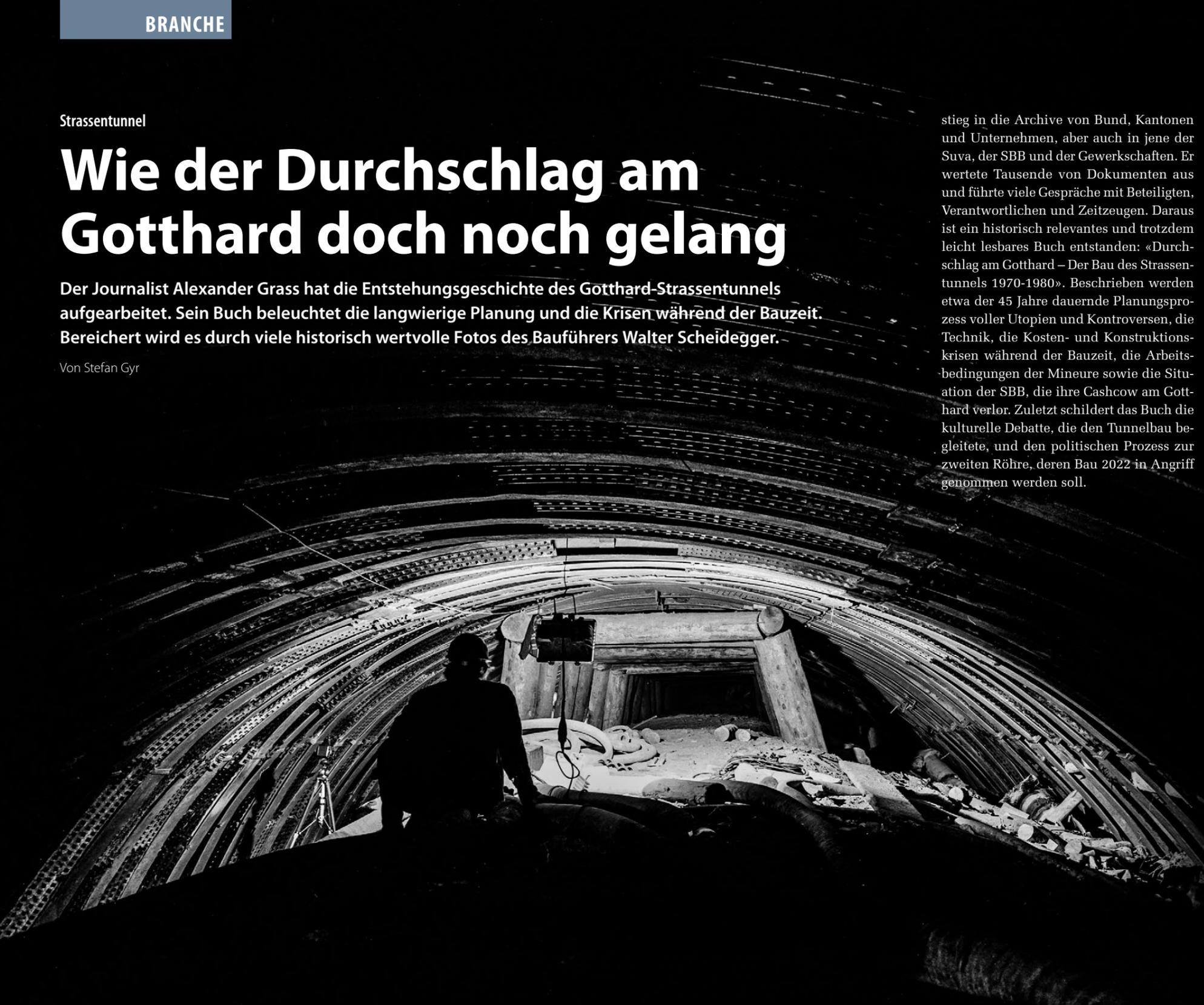
20.6.1975, Haupttunnel: Zwischenangriff im Paragneis. Ausbruch der Kalotte und Verstärkung des Stahleinbaus mit mächtigen Holzbalken.
