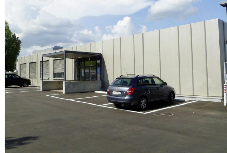
Das Gebäude der Spitalpharmazie des Kantonsspitals Aarau erhielt bei der Sanierung eine neue Fassadenverkleidung aus pulverbeschichtetem Aluminiumblech.
