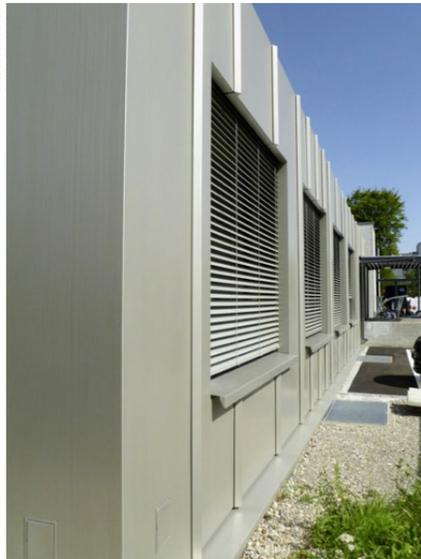
Der mit einer speziellen Technik behandelte Pulverlack wurde mit einem Besenstrich versehen und anschliessend eingebrannt.
