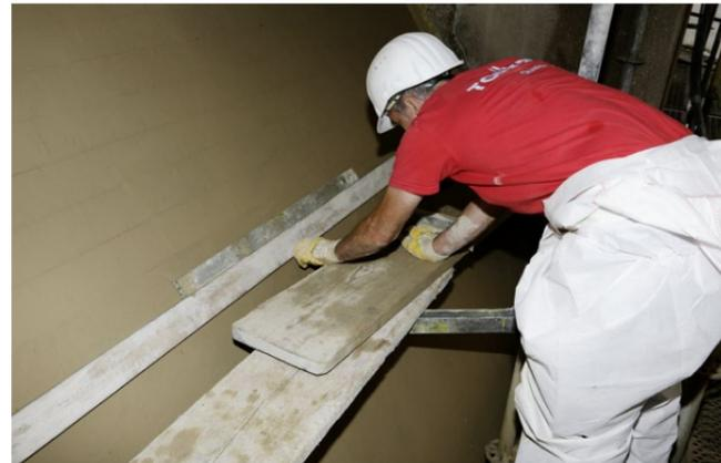
Um die ursprüngliche Brettschichtschalung nachzuahmen, wird mit einer Traufel von Hand eine Profilierung eingearbeitet.
