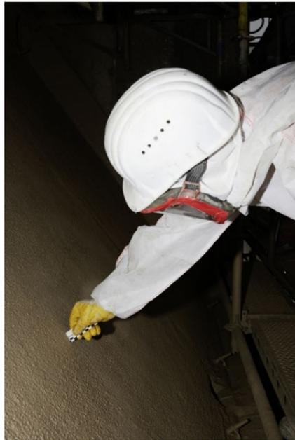
Unmittelbar nach dem Spritzen prüft der Polier die Schichttiefe mit einer Messlehre.
