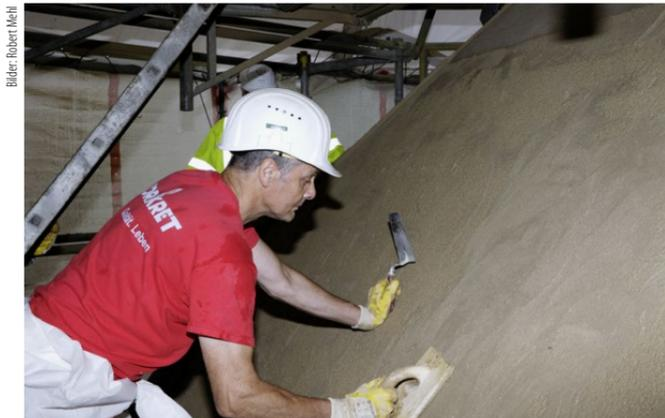
Nun wird die Dachfläche mit einem Reibebrett abgerieben und Fehlstellen von Hand mit einer Kelle beigearbeitet.
