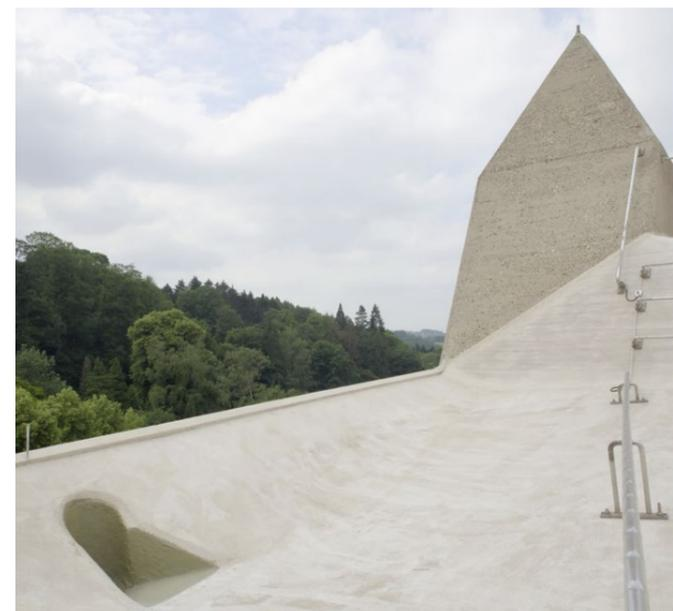
Gut erkennbar sind das Sammelbecken für Regenwasser auf dem Dach der Gnadenkapelle und die Ableitung mittels innenliegendem Fallrohr.
