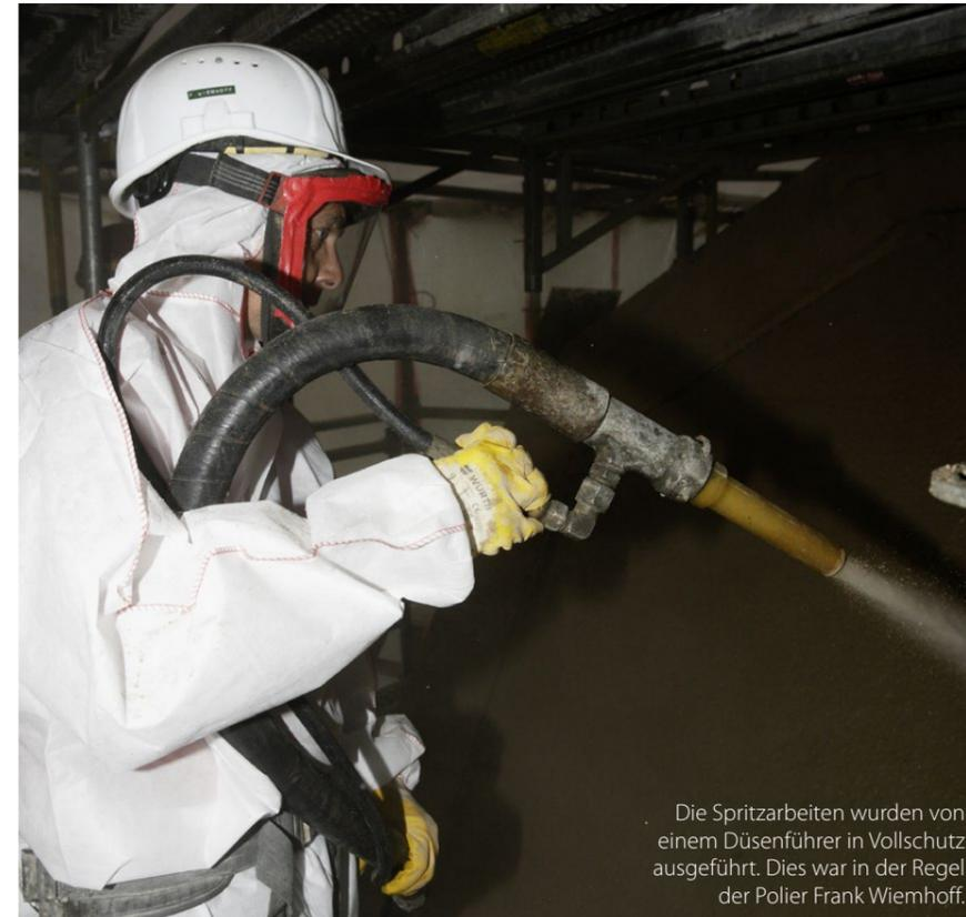
Die Spritzarbeiten wurden von einem Düsenführer in Vollschutz ausgeführt. Dies war in der Regel der Polier Frank Wiemhoff.
