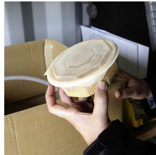
Die Pigmente zum Einfärben des Spritzbetons wurden nach dem Abwiegen in kleinen Behältern bereitgehalten.
