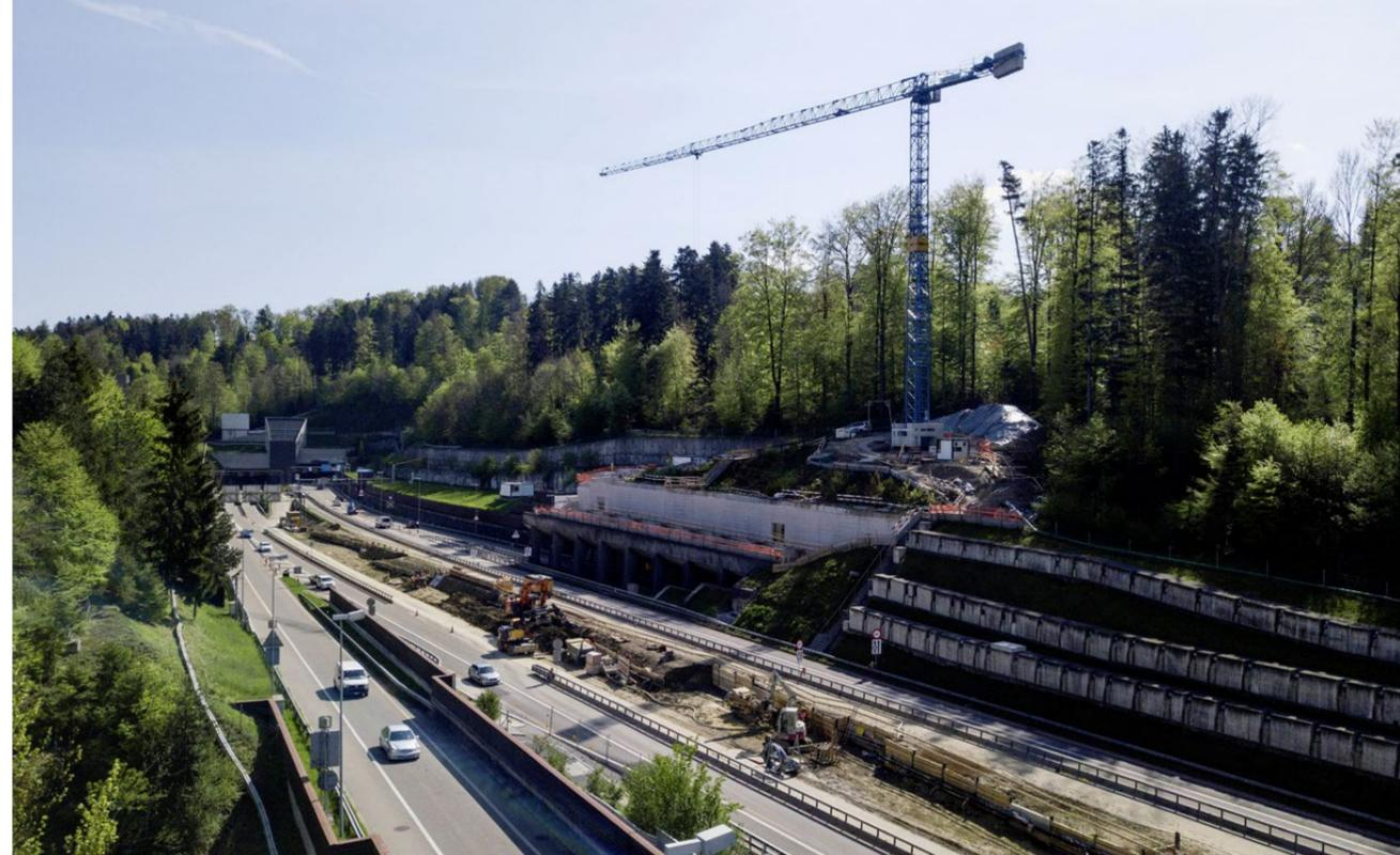
Die Vorarbeiten beinhalteten die Erstellung von Überleitungssystemen sowie die Sicherung des Rutschhangs Dietli beim Anschluss Kreuzbleiche.
