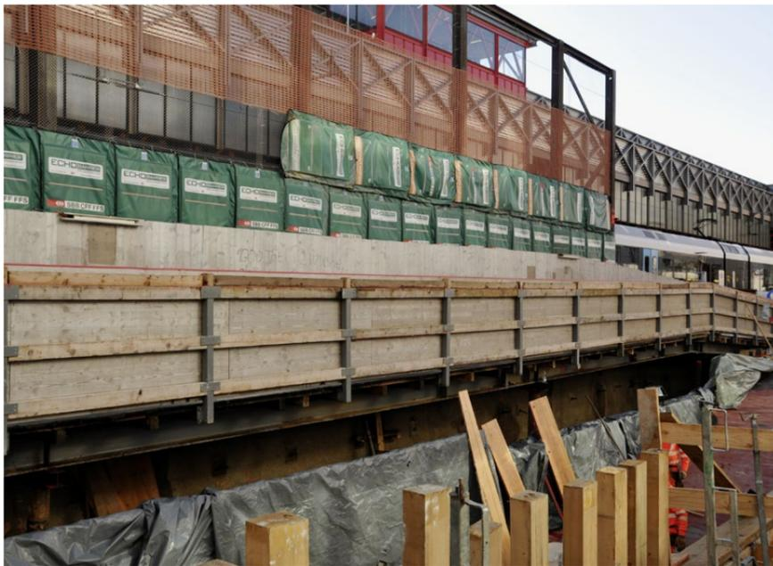
Zum Schutz der Anwohnerschaft wurden vielerorts Schallschutz-Matten angebracht, welche den Lärm der Baustelle dämpfen. Solche Matten kommen bei SBB-Bauarbeiten des Öfteren zum Einsatz.
