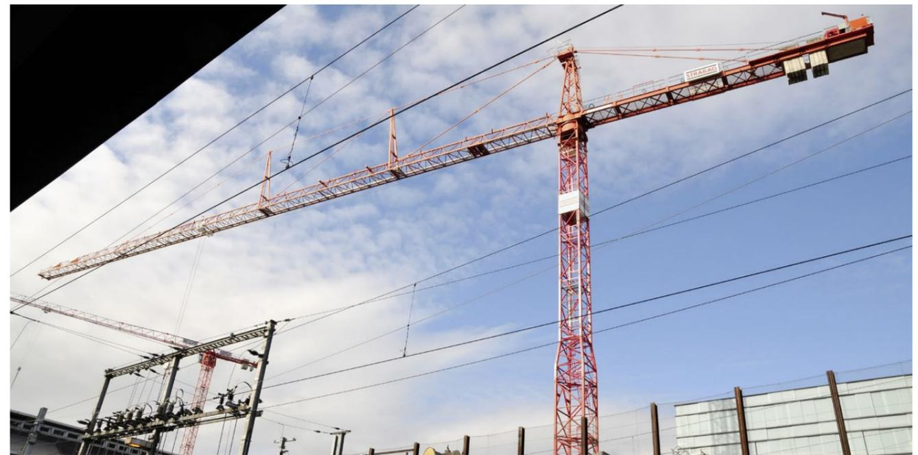
Die gesamte Baustelle wird mit einem Kran bedient. Der 90 Meter lange Ausleger des Turmdrehkrans kann Material übers ganze Bahnhofdach hinweg auf der anderen Seite aufnehmen und abladen.
