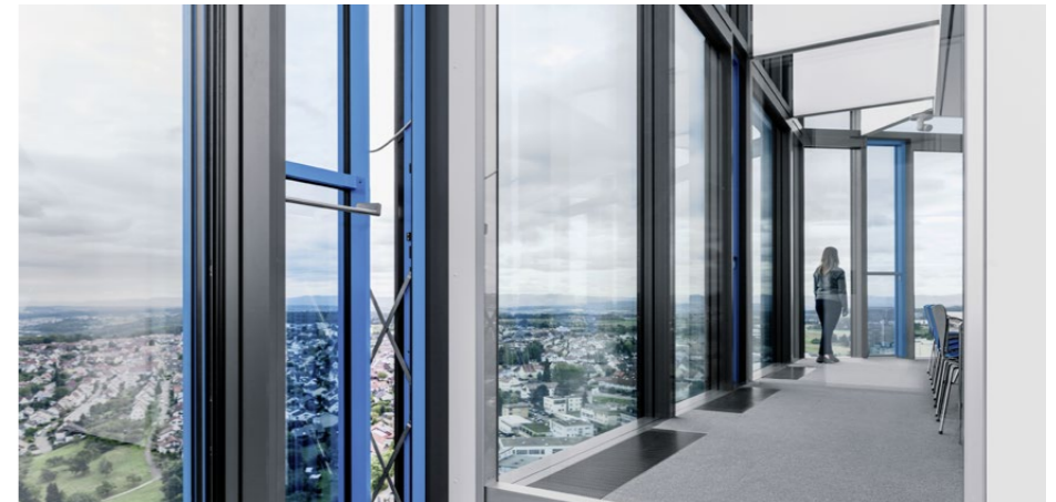
Gebäudeklimatisierung im «AutomationCenter»: Der innere Blendschutz, die vierseitigen Aluminiumbauteile der Elementfassade und die Verglasung begrenzen ein Luftvolumen, das bei direkter Sonneneinstrahlung permanent abgesaugt wird.
