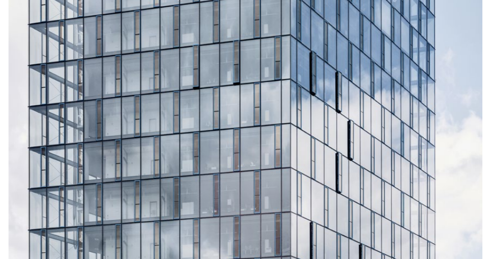
Die Glasfassade misst 8500 Quadratmeter und ist als Abluffassade konstruiert. So lässt sich bis zu 35 Prozent Energie bei der Klimatisierung des Gebäudes einsparen.
