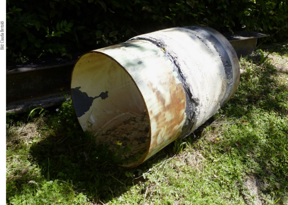
Ein Teilstück der im Erdreich verlegten Rohrleitung der Wasserfassungsleitung. Sie hat einen Durchmesser von 600 Millimetern und kann mehr als 600 Kubikmeter pro Stunde fassen.
