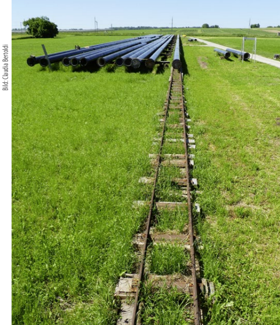
Der Montage- / Schweissplatz liegt auf einem ufernahen Feld in Güttingen.
