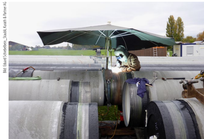
Die Teilstücke der offen verlegten Leitung werden zu 60 Meter langen Strängen verschweisst und anschliessend am Seegrund verschraubt.
