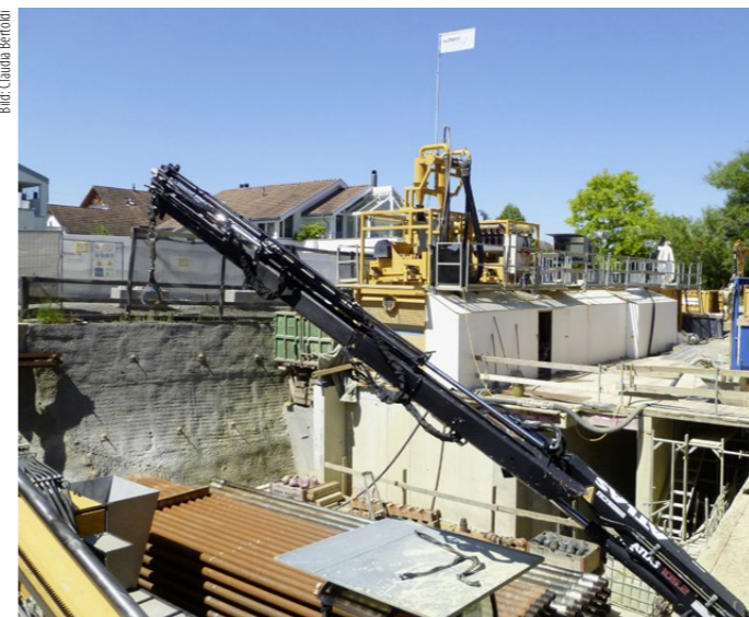
Hinter dem Seewasserwerk Kesswil wurde die Baustelleneinrichtung inklusive der Aufbereitungsanlage für die Bohrflüssigkeit untergebracht.
