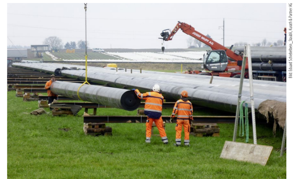
Die Anlieferung der 16 Meter langen Teile der Seewasserfassung auf dem Schweissplatz in Güttingen.
