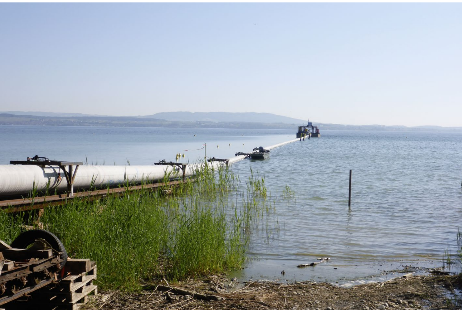
Das Einbringen der über 500 Meter langen, zusammengeschweissten Leitungen der Seewasserfassung erfolgt über einen Schienenstrang.
