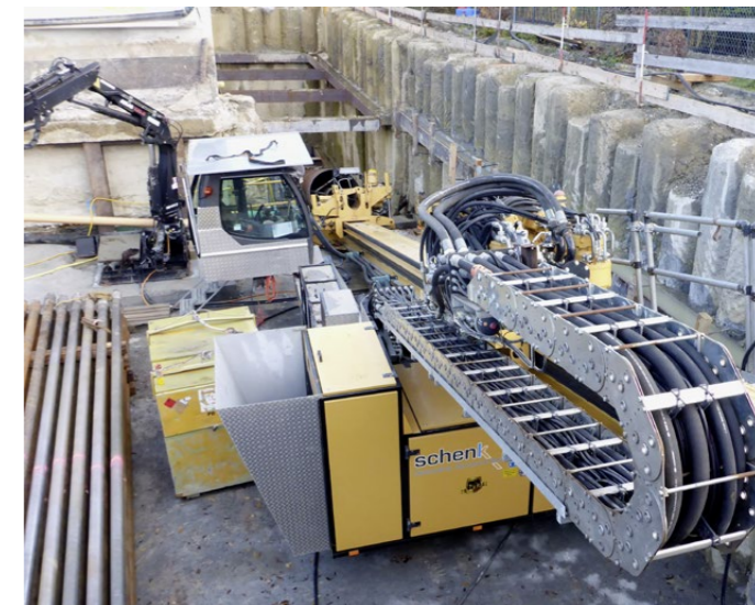
Die Bohrungen der neuen Fassungsleitungen von über 500 Metern Länge am Seewasserwerk Kesswil sind inzwischen fertiggestellt.
