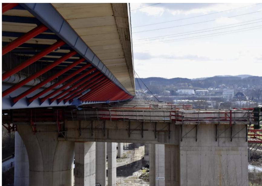
Der Überbau sitzt nun auf seinen endgültigen Pfeilern. Der Rückbau der Vershubbahnen und der Arbeitspfeiler kann nun im Anschluss erfolgen.
