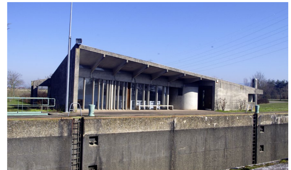
Im Untergeschoss des Verwaltungsgebäudes für Zoll- und Schiffskontrolle befinden sich Diensträume, Heizung und Garage.
