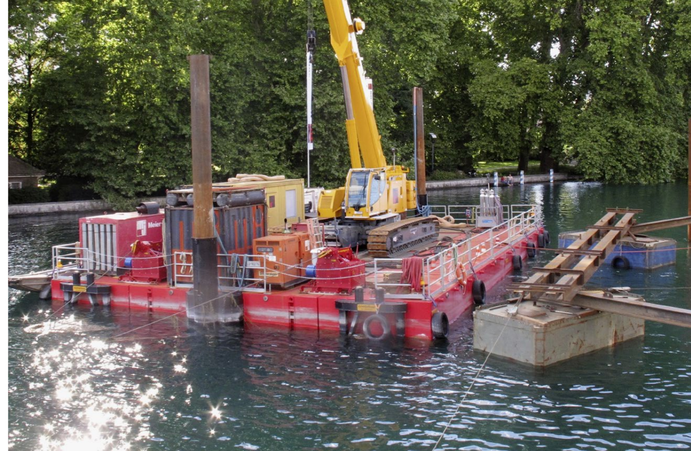
Corona dürfte beim Wohn- und Bürobau zu einer Wachstumsdelle führen. Bild: Pfähle werden ins Flussbett der Limmat gerammt als Fundament für ein Büroprovisorium.
