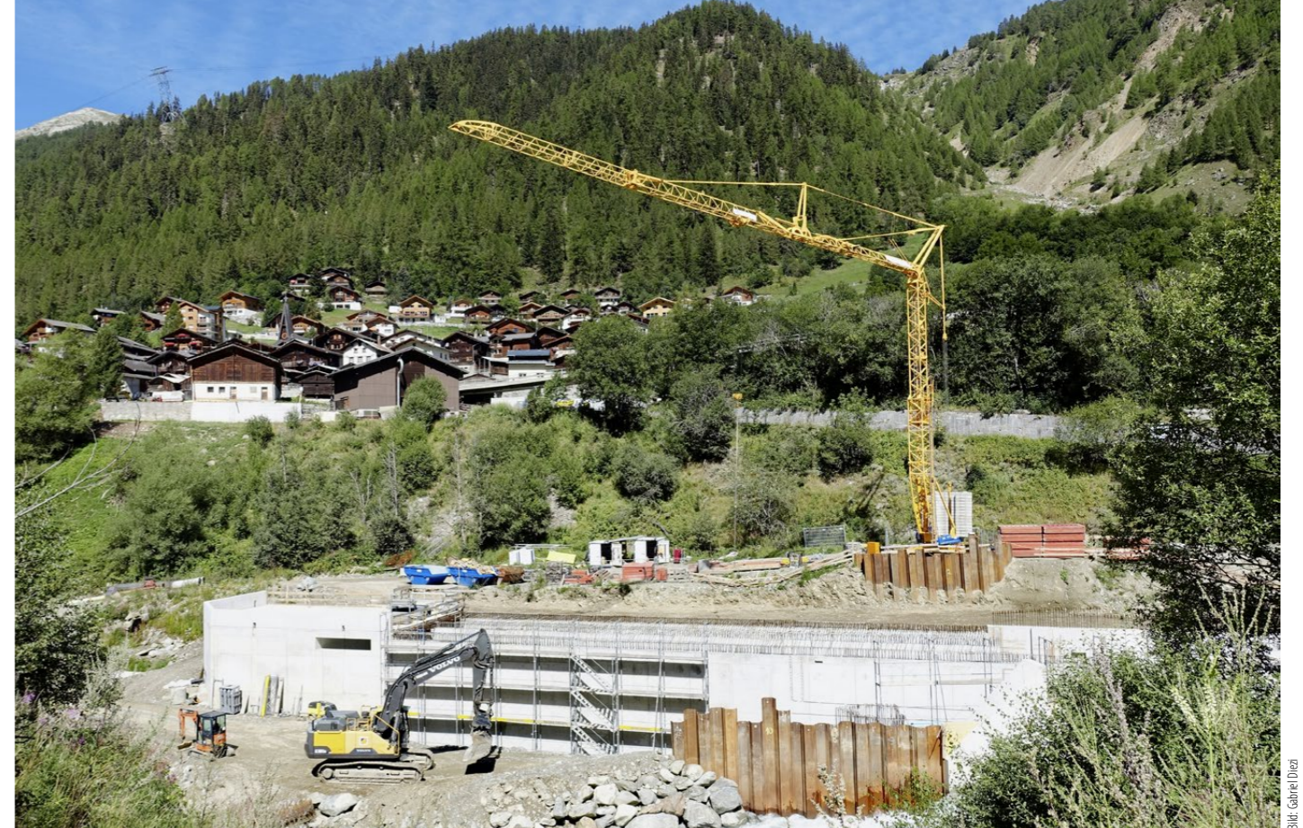
Während sich dieses Jahr die geplante Hochbausumme abschwächen dürfte, könnten Infrastrukturprojekte den Rückgang teilweise kompensieren. (Bild: Wehr für die Wasserfassung des neuen Kraftwerks Wiler-Kippel VS).
