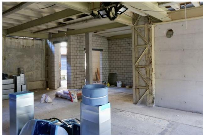
Ein ungleiches Paar im Erdgeschoss: Altgediente Stahlträger und frisch betonierte Wände, welche die Erdbebensicherheit gewährleisten.
