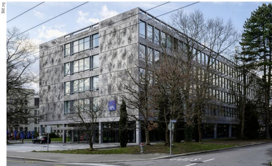
Bei der Sanierung des Axa-Bürogebäudes an der Winterthurer Römerstrasse wurde der Bausubstanz Sorge getragen. Auch die originalen Fassadenplatten aus Gussaluminium blieben erhalten.
