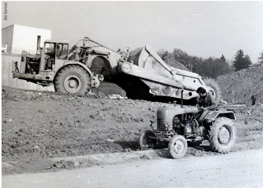
Ein Scraper im Jahr 1973 im Einsatz bei den Umgebungsarbeiten an der ETH Höngrgerberg.
