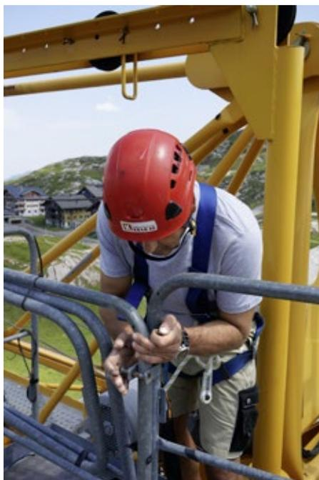
Obendreher mit einer Hakenhöhe von 25,6 Metern und einem 45-Meter-Ausleger im Gebirge Pflicht, um die notwendige Standsicherheit zu garantieren – im Flachland würden beim gleichen Kran 45 Tonnen vollkommen ausreichen. «Melchsee-Frutt liegt in der Windzone D25, denn Böen und Sturmwinde sind hier oben keine Seltenheit», erläutert Rieder. Beruhigt nimmt er zur Kenntnis, dass die Ballastierung am Fusse des Turms stimmt.
