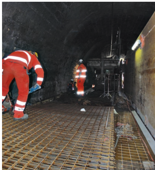
Die Armierungen werden vor Ort zurechtgeschnitten und eingepasst.
